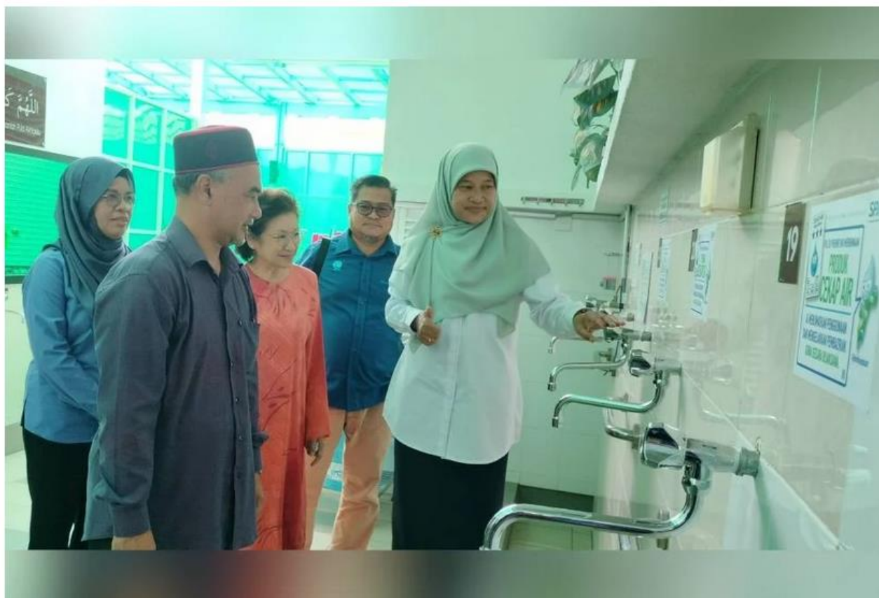
Nor Azrina (kanan) meninjau penggunaan pili cekap air yang baharu dipasang di Masjid Andalusia Bandar Laguna Merbok, Sungai Petani Kedah.
